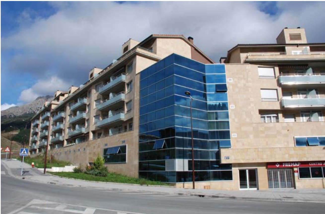
Arrasate. Garaia 70 viviendas. Año 2007.
