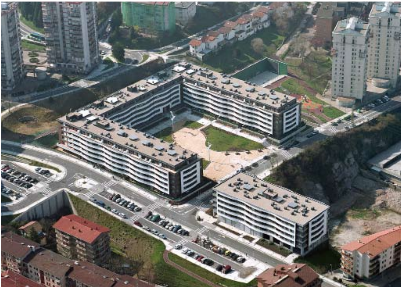
DESPUÉS del traslado de la antigua fábrica de Nerecán en Alza, Donostia. Construcción de 248 viviendas.
